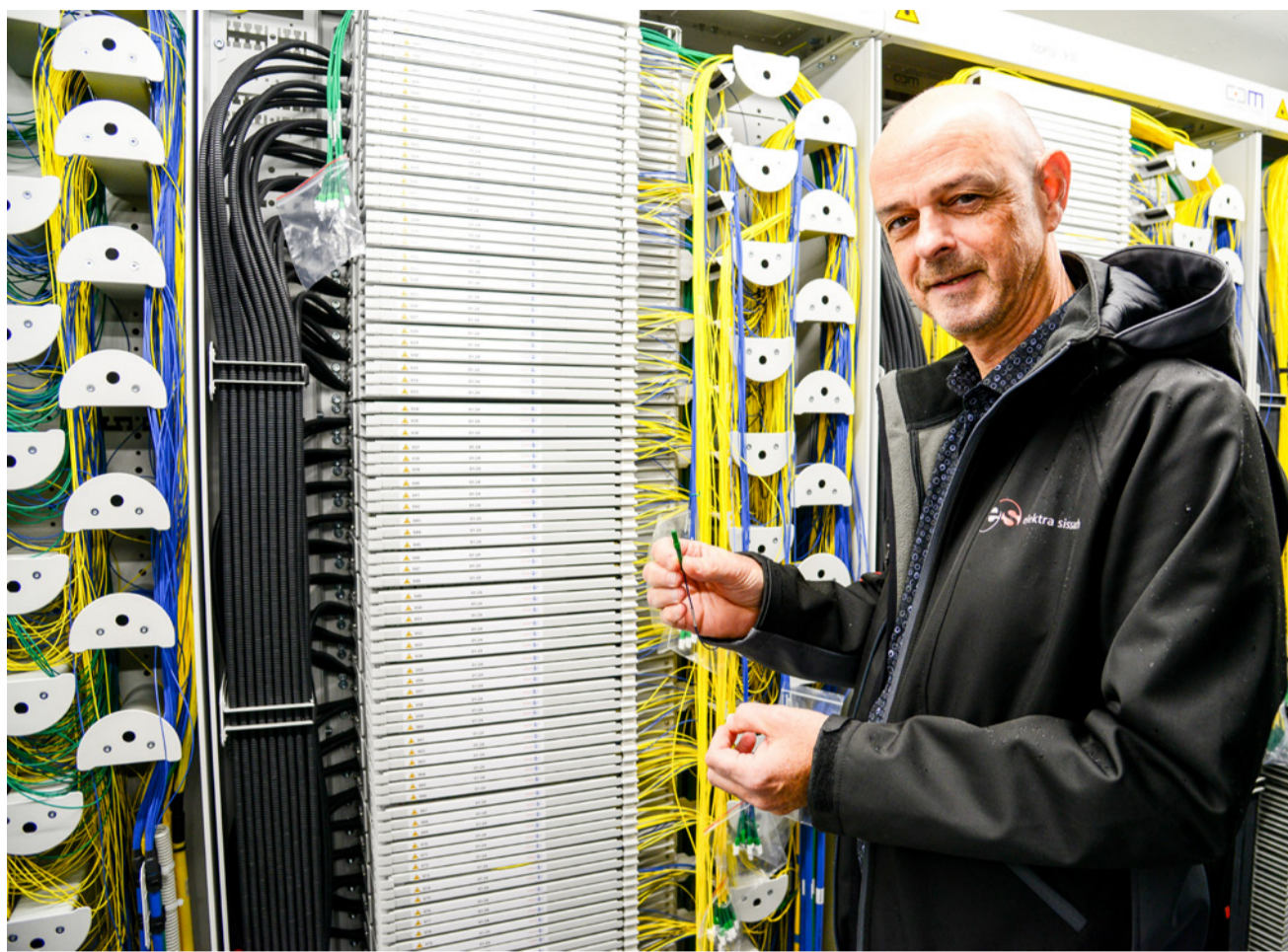
17 815 Kilometer Glasfasern verlegt: Stephan Jurt, Geschäftsführer der Elektra Sissach, in der «sissanet»-Zentrale. Bilder ch.
