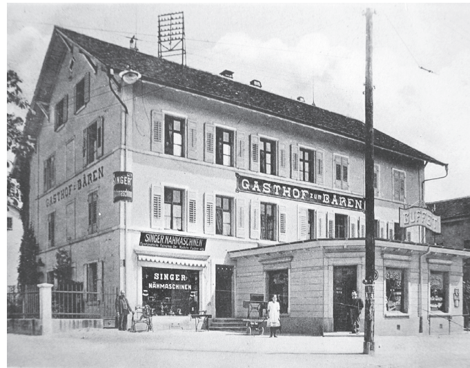
Elektra Sissach am Standort beim Gasthof zum Bären, Bahnhofstrasse 11 (1934–1959)
