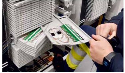
Aufschalten der Glasfasern in der Technikzentrale.
